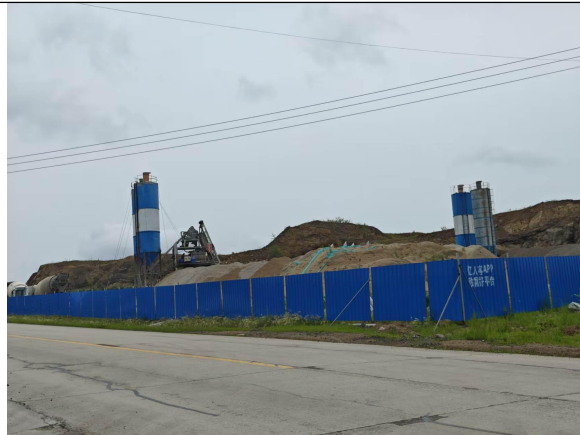
厂界南侧隔道路为临时商品混凝土搅拌站
