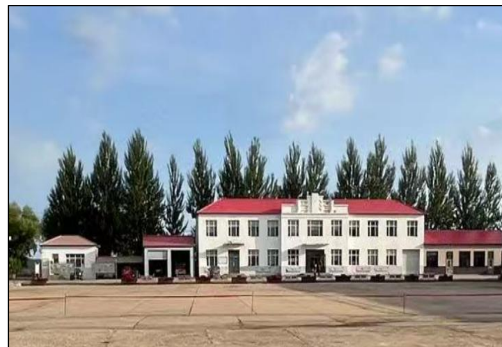
项目北侧为现有辅助用房
