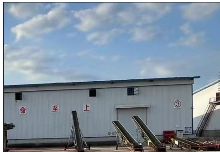
项目南侧为现有粮仓
